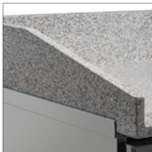
20 cm de peto construido en granito.
