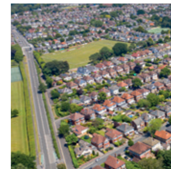
Sistemas centralizados para viviendas
